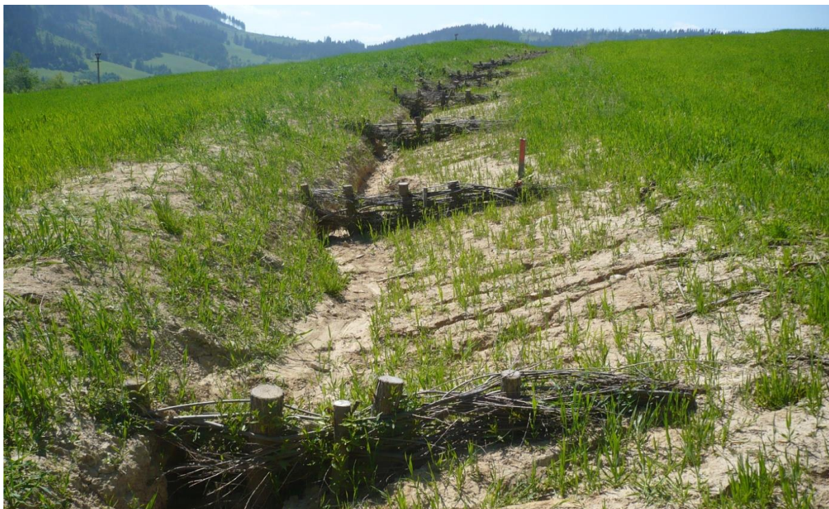
Rys. 6. Umocnienie bruzdy erozyjnej poprzez zastosowanie płotków faszynowych (fot. M. Madzia).
