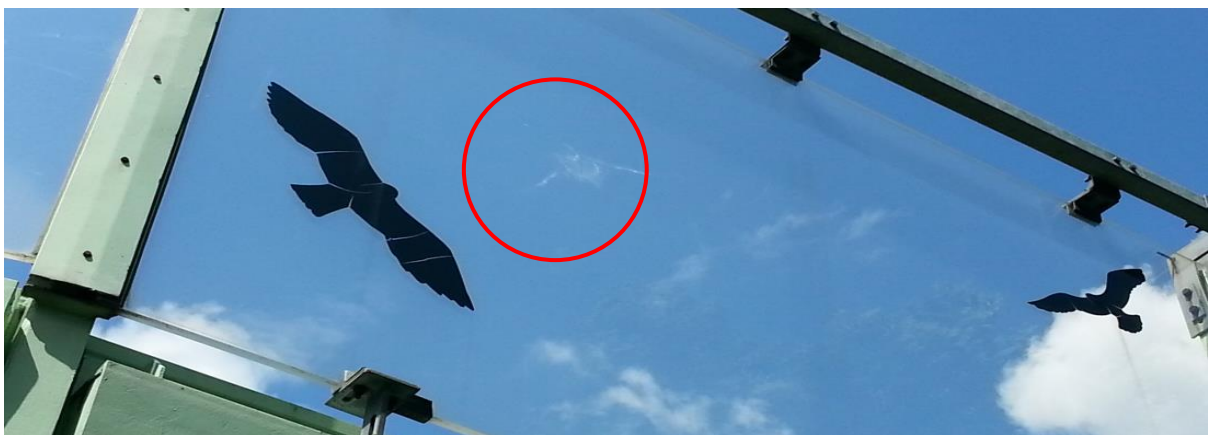
Rys. 6. Ekran oklepany sylwetkami ptaków drapieżnych wraz z miejscem uderzenia ptaka; zdjęcie to jest idealną ilustracją, że sylwetki odbierane są jako zwykłe plamy, które ptaki omijają (fot. M. Adamczyk).
