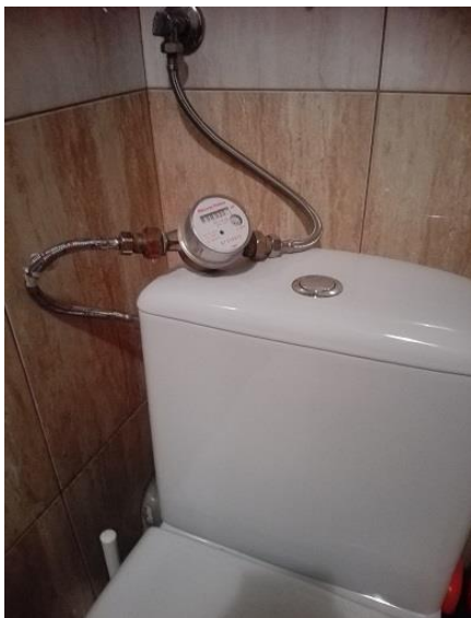
Rys. 2. Pomiar zużycia wody w toalecie (fot. K. Ratowska). Fig. 2. The measurement of water use in the toilet (photo by K. Ratowska).
