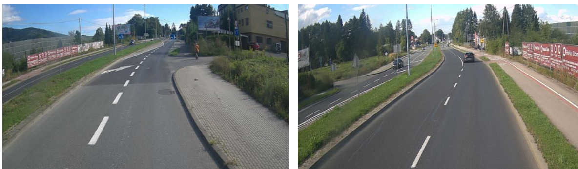
Rys. 1. Skrzyżowanie ul. Bystrzańskiej z ul. Przedwiośnie przed realizacją inwestycji (fot. A. Pernal).
